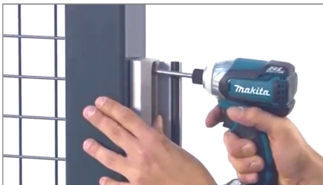
5. Установить ответную планку в ранее просверленные отверстия в столбе
