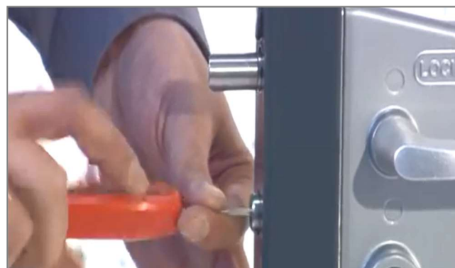
6. Выставить язычок замка в нужном направлении
