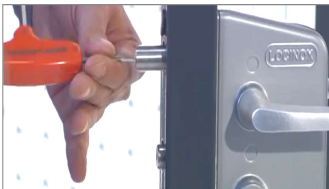
5. Установить ответную планку в ранее просверленные отверстия в столбе
