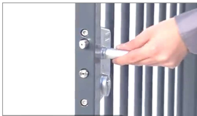
2. Подтянуть болты для устойчивой фиксации замка в калитке
